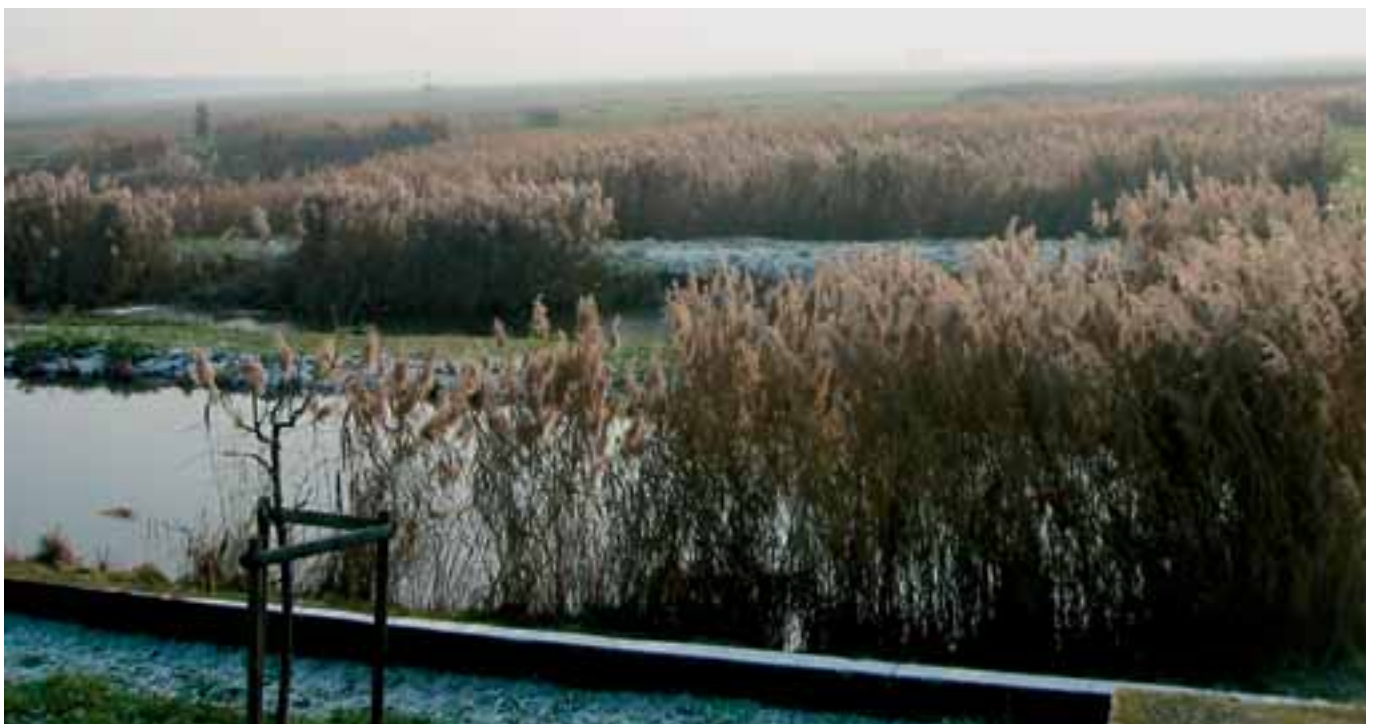
Il bacino dell'impianto di fitodepurazione realizzato a Sozzago (NO) da A.I.A. Ovest Ticino - foto archivio A.I.A.
