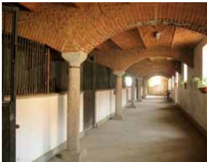
Scuderie alla Cascina Montelame di Pombia - foto di M. Fonio
